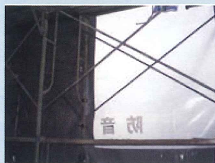
作業側から見た状態
